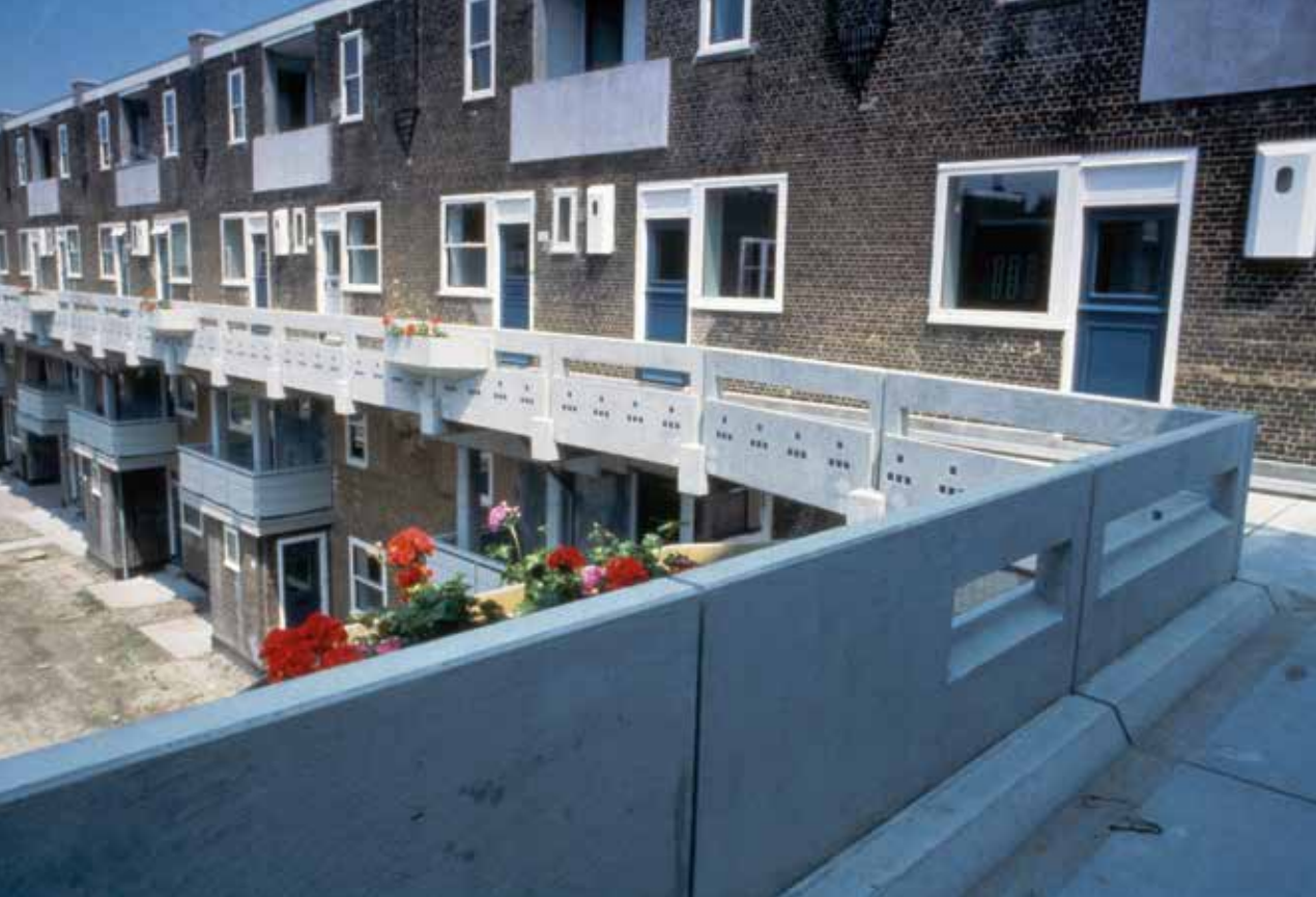
Het Justus van Effencomplex in nog tamelijk originele staat; de kozijnen zijn voor een deel vervangen door nieuwe zonder roeden
